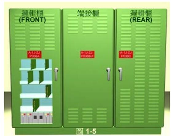
現場輸出緩衝板( Field Buffer Modules FBM )卡片內之BCM1、BCM2監視迴路功能說明，若控制設備不正常或現場失電狀態下，迴路監視到不正常現象，該迴路透過光電晶體連接至萬用邏輯板( ULM)再經控制緩衝板( Control Buffer Modules CBM )至控制室的控制開關告知運轉操作人員，設備運轉狀況，這種設計是為了確保設備可用性。
