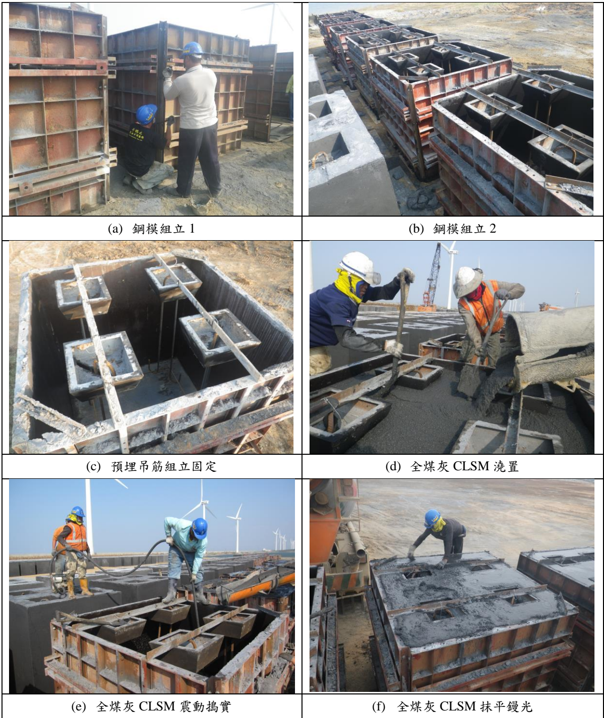
圖 3-19 全煤灰 CLSM 預鑄方塊澆置及吊放施工過程(1/2) [26]
