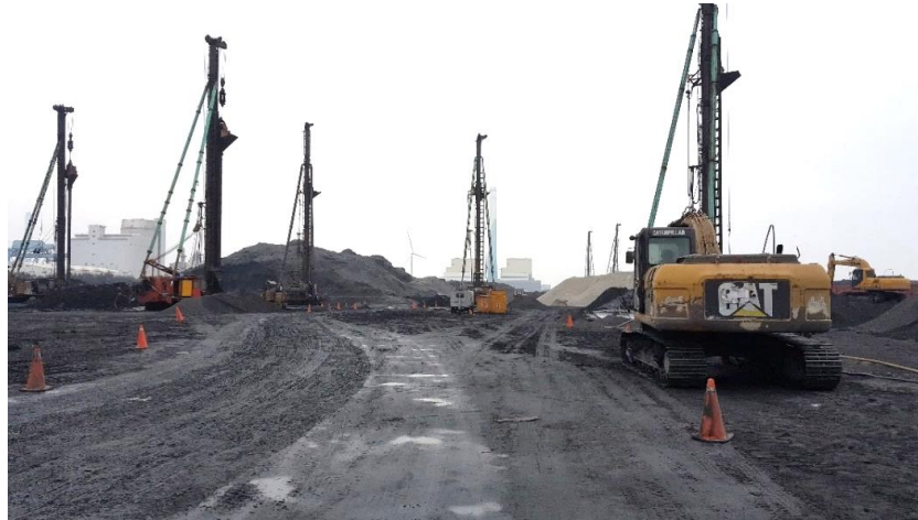
圖 3-6 擠壓砂樁施工情形 [24]
