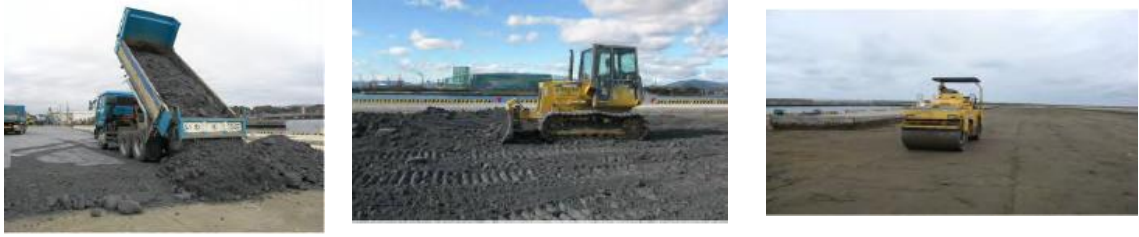
圖 3-49 日本福島縣盤城市港區臨時道路臨時道路之現場施工情形 [2]
