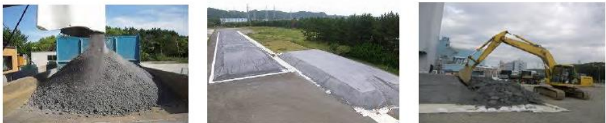
圖 3-48 日本福島縣盤城市港區臨時道路煤灰混和材料現場製作情形 [2]
