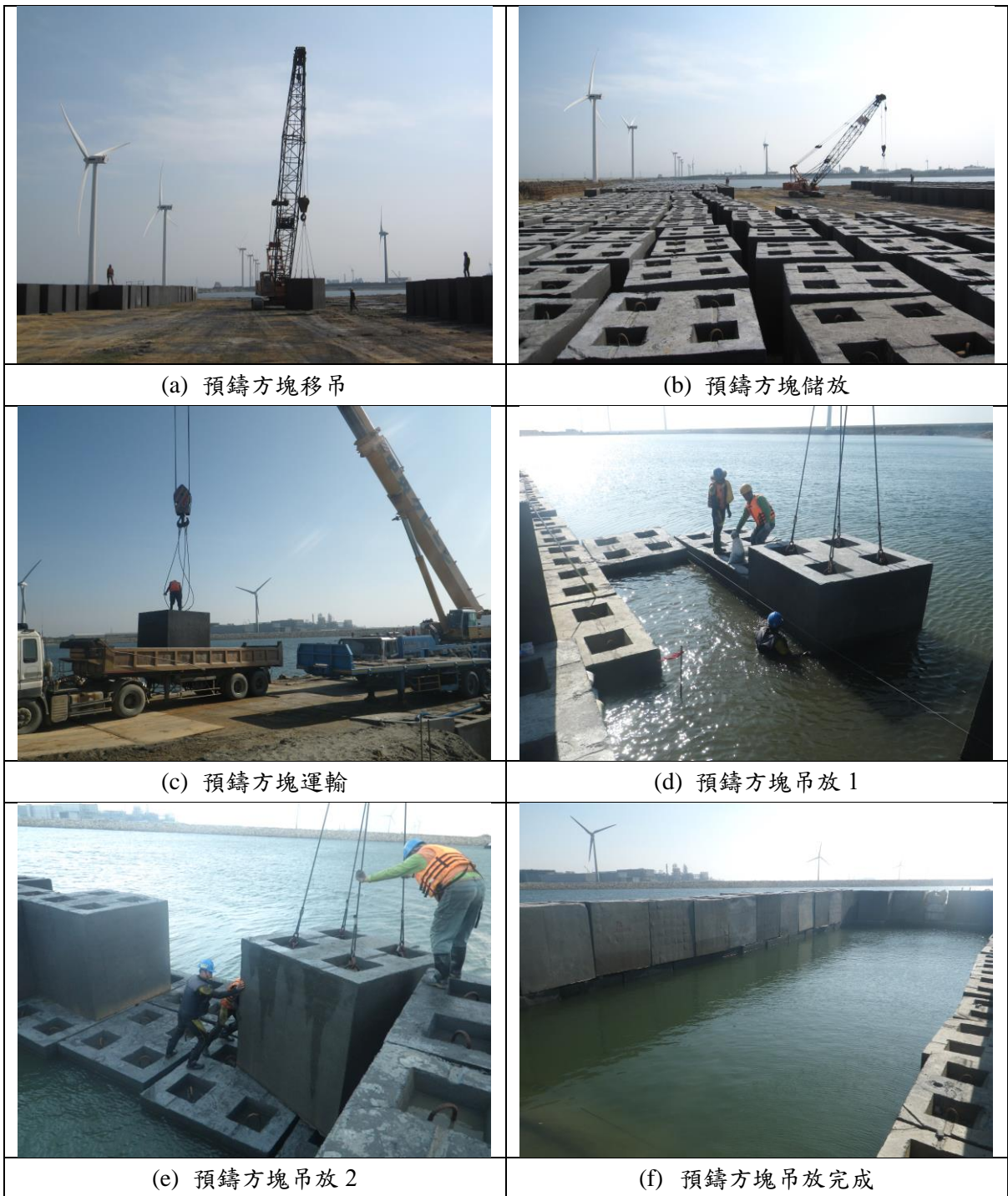
圖 3-20 全煤灰 CLSM 預鑄方塊澆置及吊放施工過程(2/2) [26]
