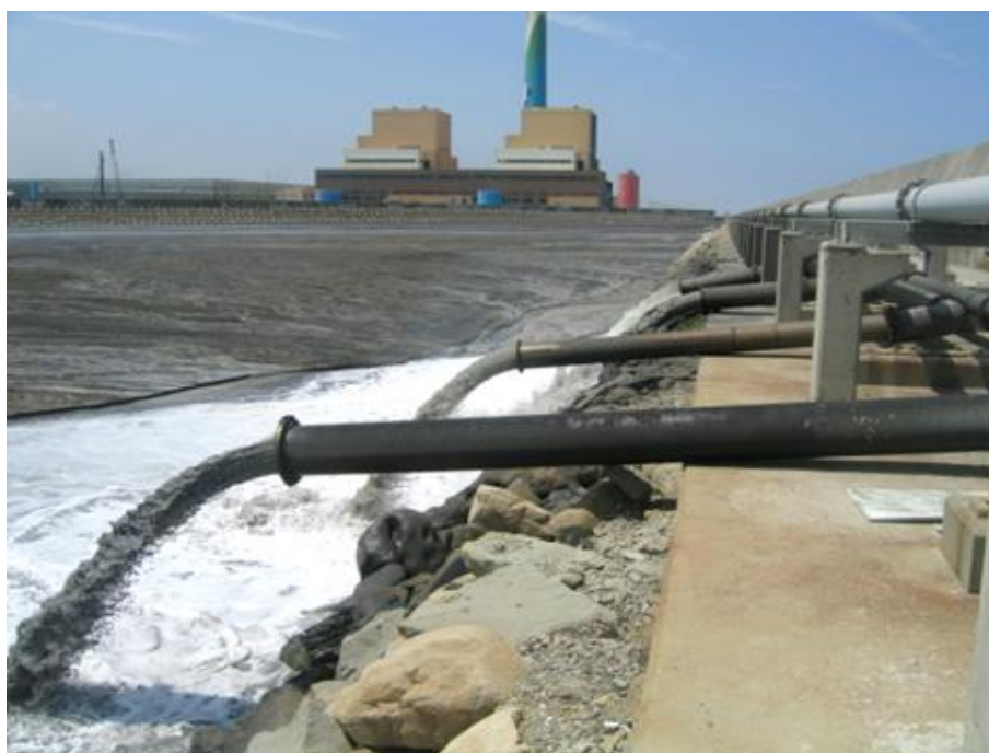
圖 3-5 台中電廠一期工程填地排灰情況(台電內部資料)
