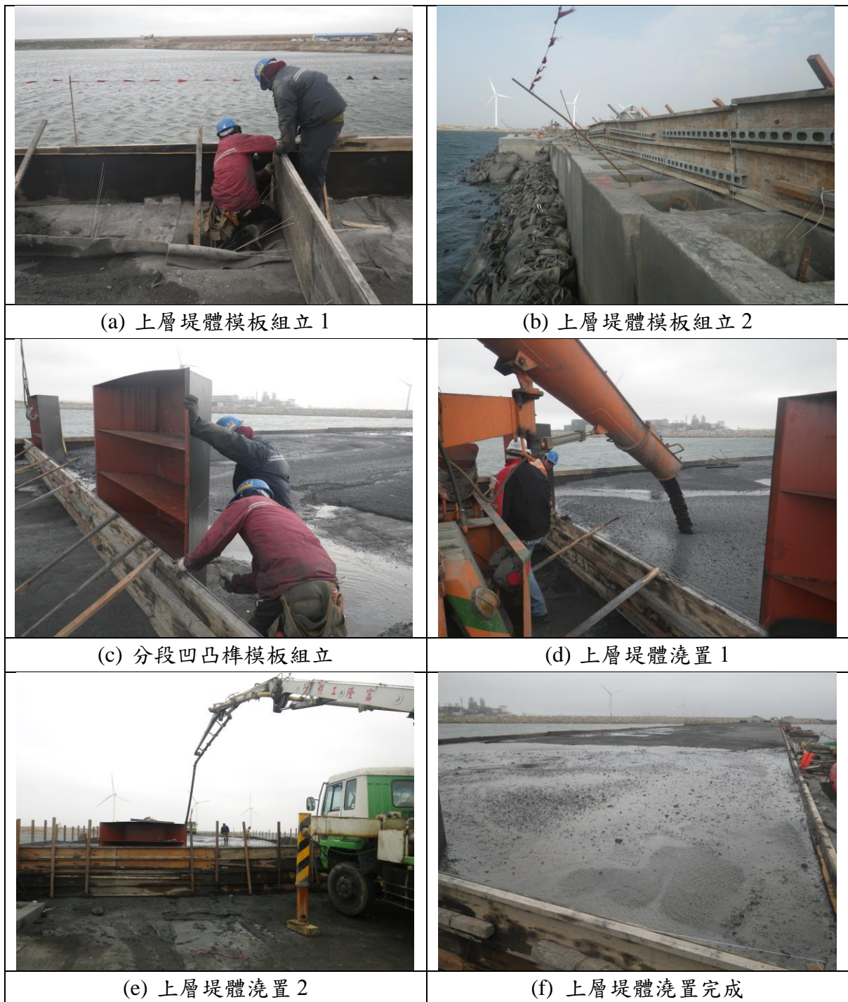
圖 3-22 東隔堤上堤體澆置 [26]
