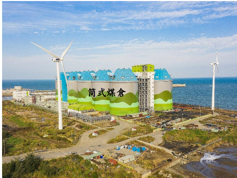
圖 3-4 林口電廠室內筒式煤倉(台電內部資料)
