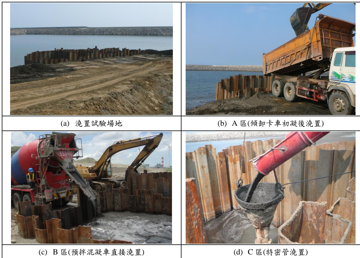
圖 3-15 現場澆置情形 [26, 29]
