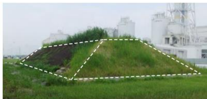
圖 3-40 Shinchi 電廠海堤完成圖 [3]
