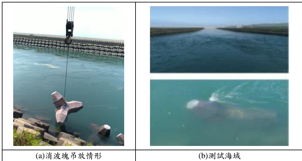
圖 3-30 實體消波塊吊放測試 [9]
