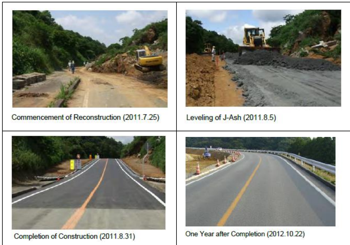
圖 3-47 日本福島縣石川線臨時道路施工及完成圖 [3]
