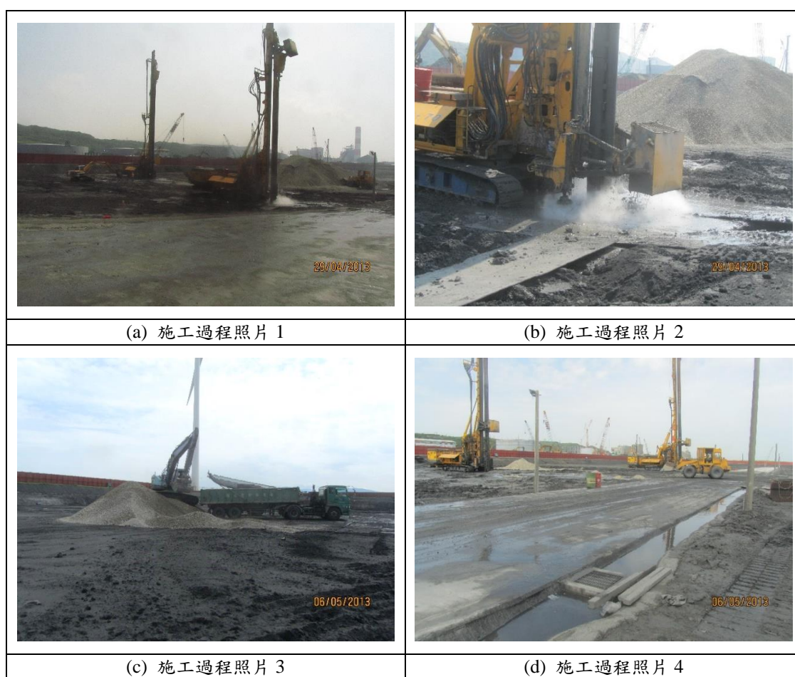
圖 3-2 礫石樁施工情形(台電內部資料)
