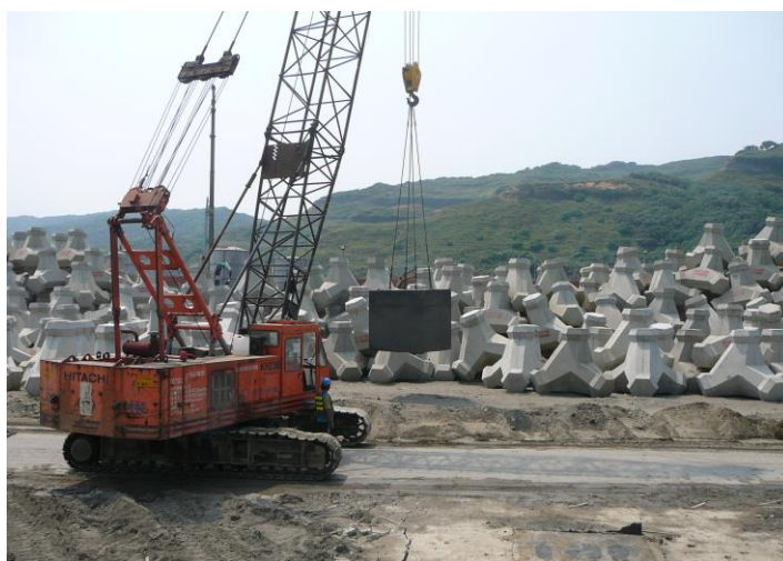
圖 3-18 全煤灰 CLSM 預鑄方塊現場試吊情形(澆置後 14 天) [26]
