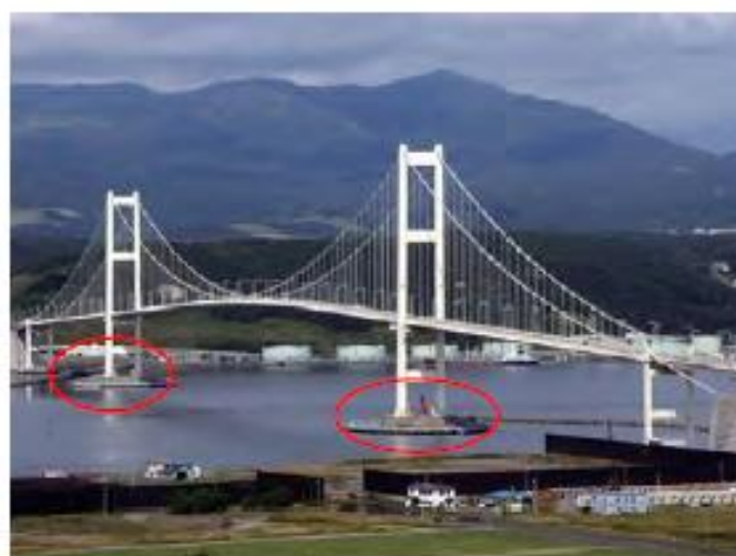
圖 3-42 Hakuchou-Oohashi 大橋橋墩臨時圍堰之施作完成圖) [3]
