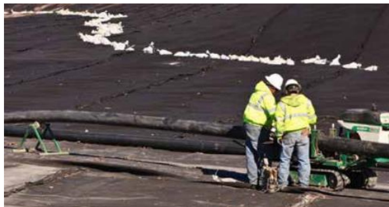
圖 3-50 Asheville 區域機場道路鋪設工程 [39, 40]
