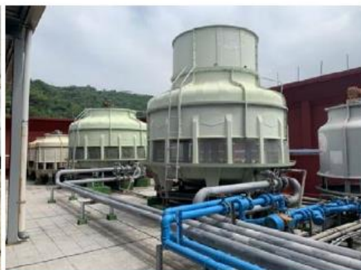
冷卻水塔為200RTx2台/套
