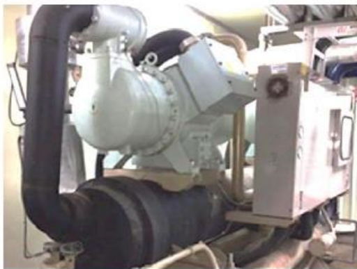
200RT螺旋式空調冰水主機
