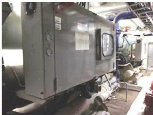
200RT螺旋式空調冰水主機
