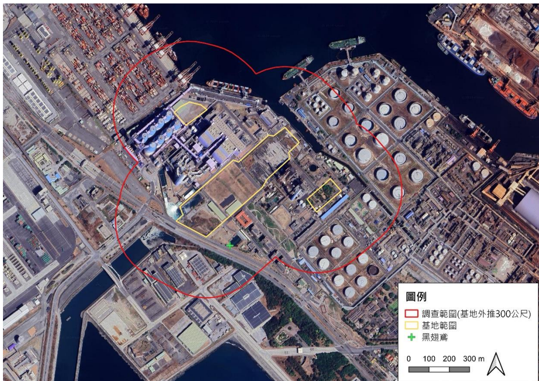
圖六、施工前(113年5月)調查保育類動物發現位置
