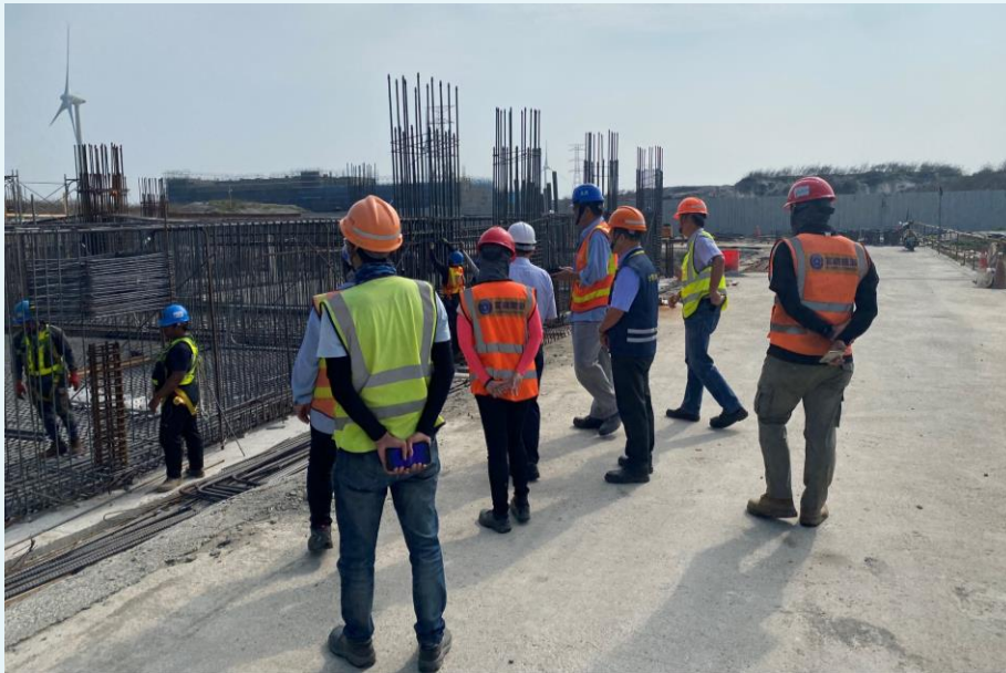
於工程場址進行工安查核
