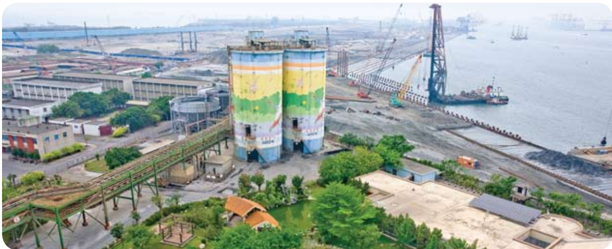
大林火力發電廠灰倉設備
