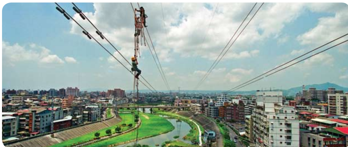
高空架線作業
