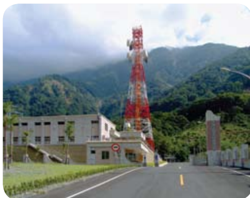
大甲溪水力發電廠谷關分廠
