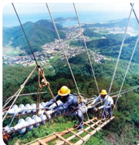
輸電線路工程安裝礙子作業
