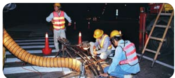
夜間搶修作業
