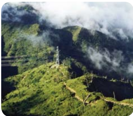
新東西線超高壓輸電線路
