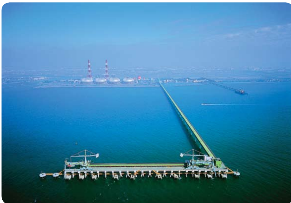
興達火力發電廠卸煤碼頭
