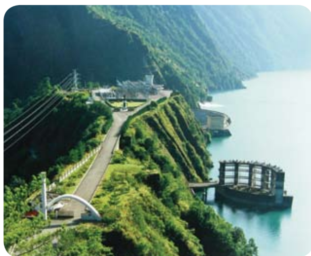
德基水力發電廠
