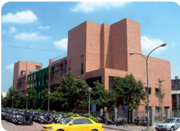
綠建築-信南變電所
