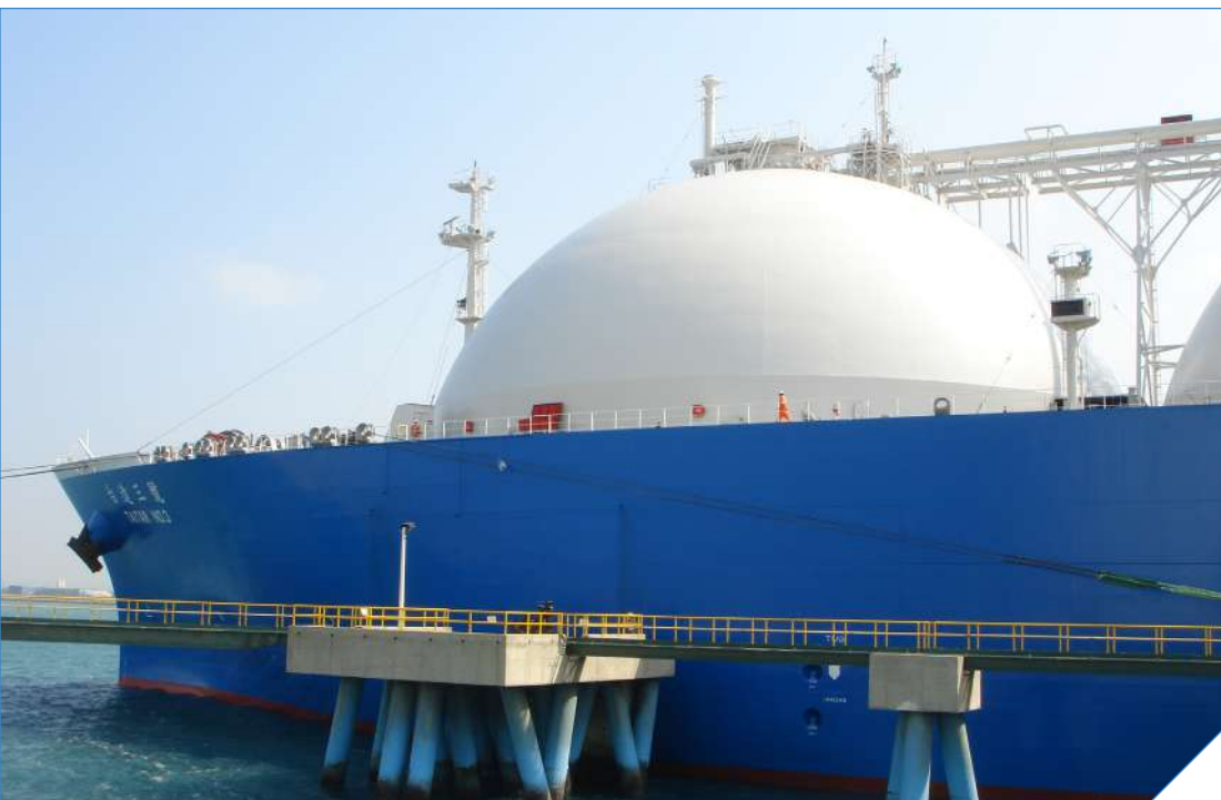
台灣中油公司 LNG 台中接收站
